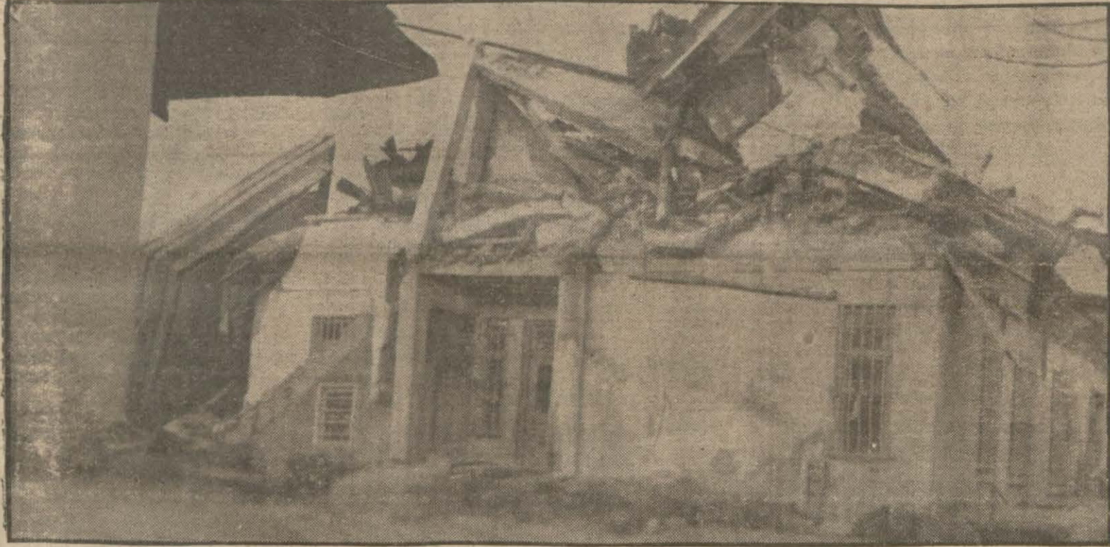
Çarşambada üç katlı bir bina bu şekilde yıkılmıştır
